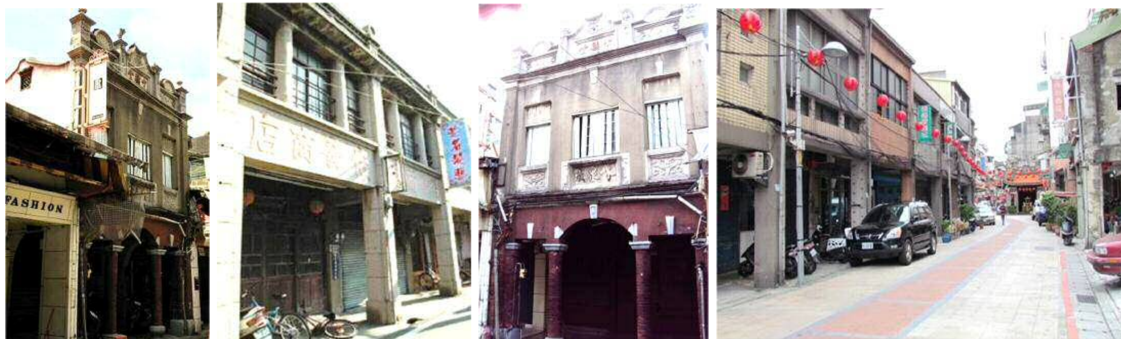
(b) (c) & (d) Remarkable shophouse façades on Xinzhuang Road
