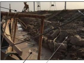
Slurry trench Landfill berm
