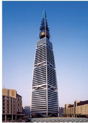
Al Faisaliah Center
