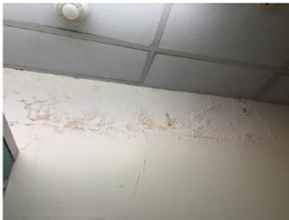
241. F13 Wall / Ceiling
