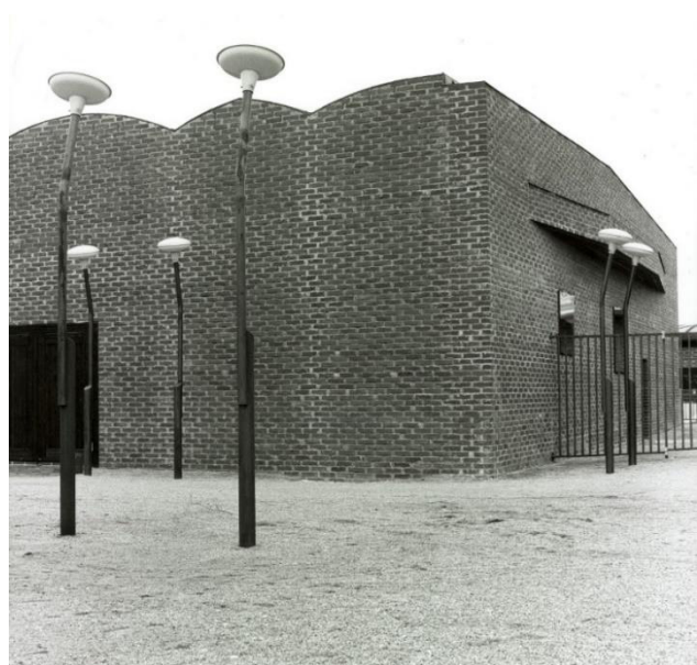
Fig. 3.4 - St Petri Kyrka Exteriör. (St Peter's Church exterior). Karl-Erik Olsson-Snoogeröd (photographer) Arkitektur-och designcentrum: ARKM.1973-103-070-530.
