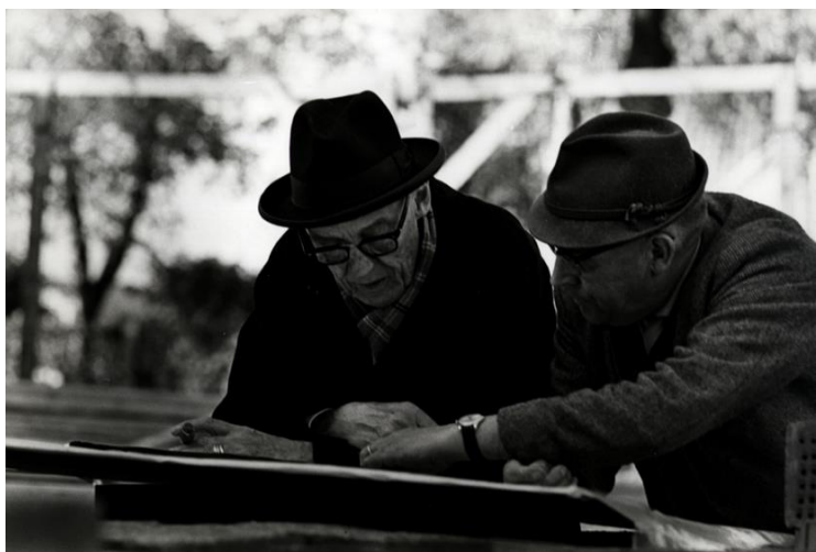
Fig. 3.14 - Sigurd Lewerentz med verkmästare Sjöholm på byggarbetsplats St Petri kyrka [Sigurd Lewerentz with foreman Sjöholm on construction site at St Peter's Church] Karl-Erik Olsson-Snogeröd (photographer) Arkitektur-och designcentrum: ARKM.1986-106-LEW-22-7.
